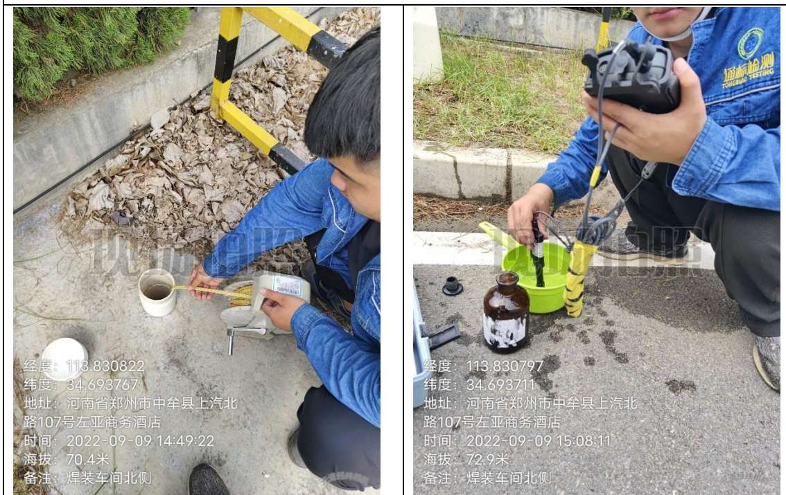
地下水监控点位☆14（焊装车间北侧）
