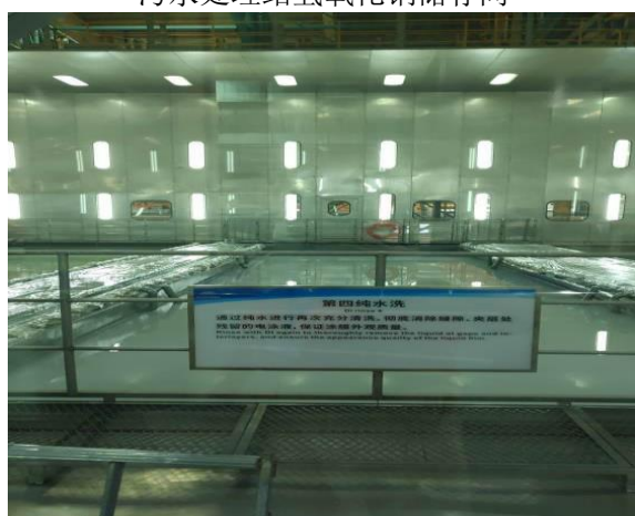
装车间水洗池
