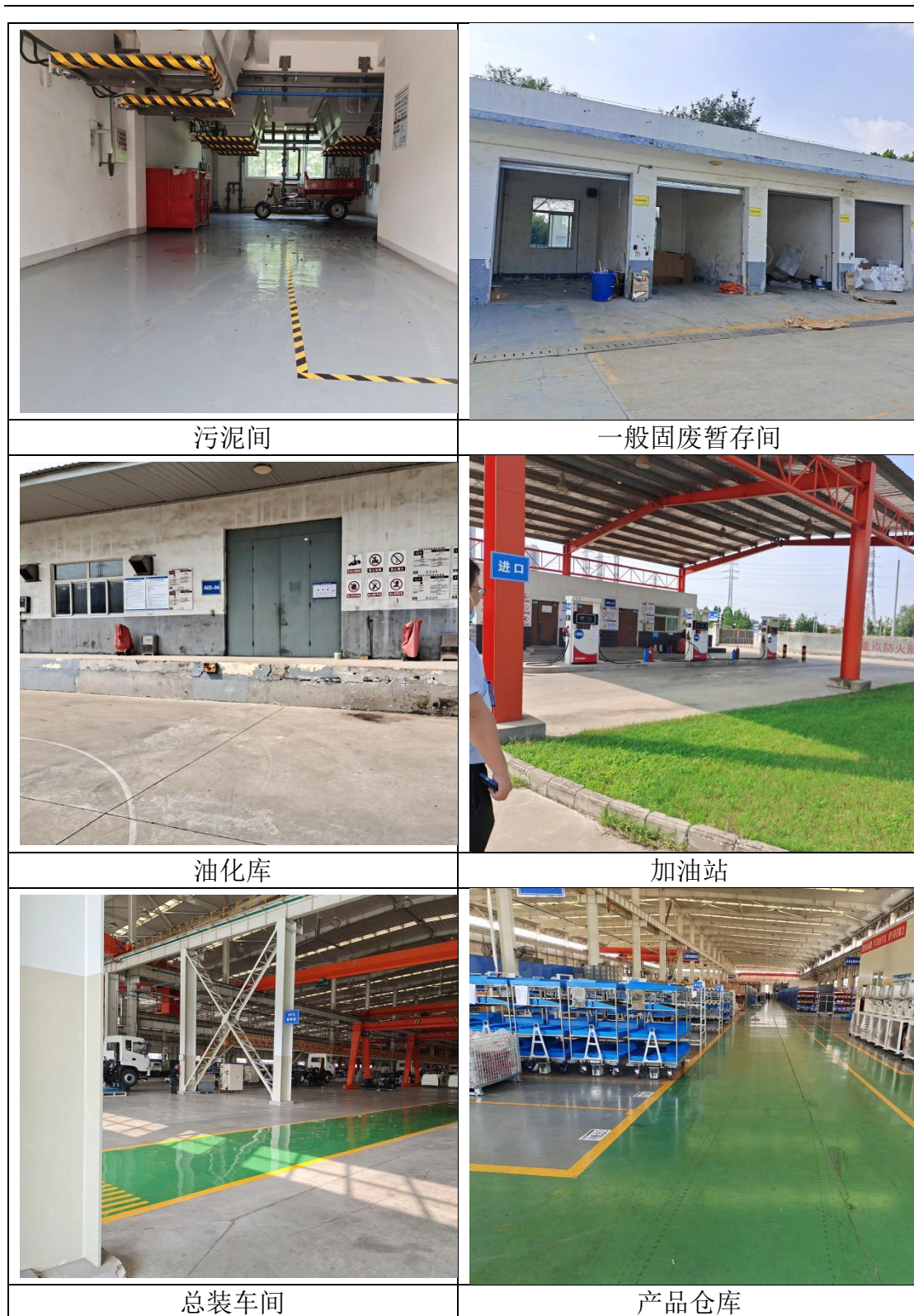
图 1-2 现场踏勘照片
