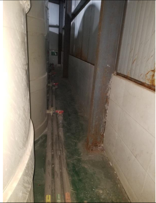
污水站地面防渗
